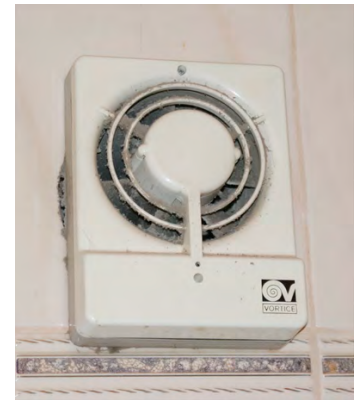
Verschmutzter Lüfter
