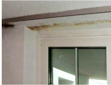
An durchgehenden Trägern und Balkonplatten
