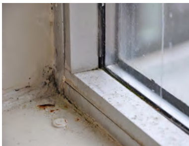
Überall dort, Wasser abrinnt und sich sammelt, wie zum Beispiel unterhalb von Fensterscheiben oder Kacheln in Bad und Küche. Besonders zu beachten sind auch Duschvorhänge.
